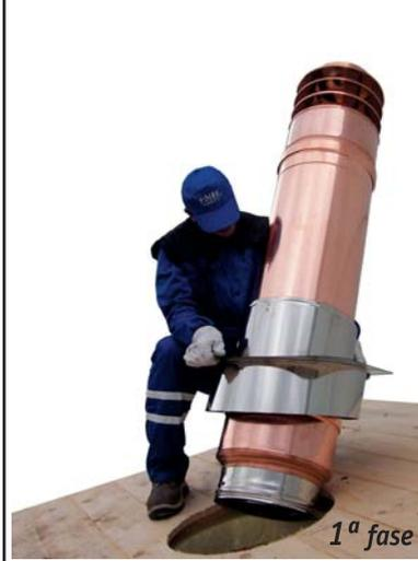
Diametro foro = Diametro interno condotto + 200 mm, Esempio: per D 200/300 = foro 400 mm.
